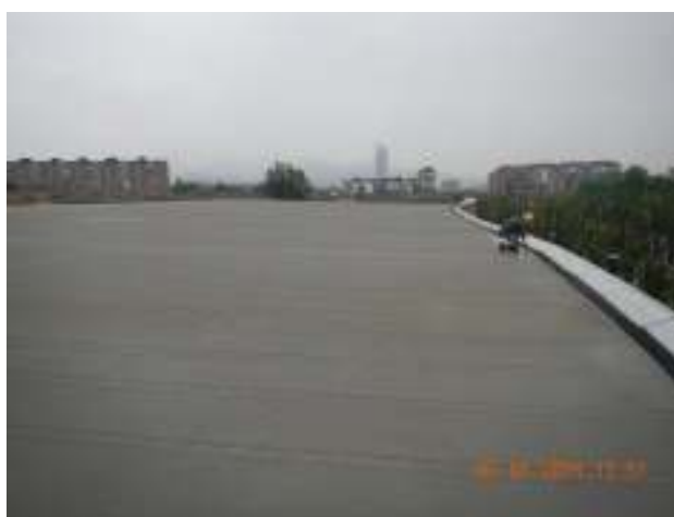
Fig. 1: Pista 1_Guaina impermeabilizzante copertura a falde
